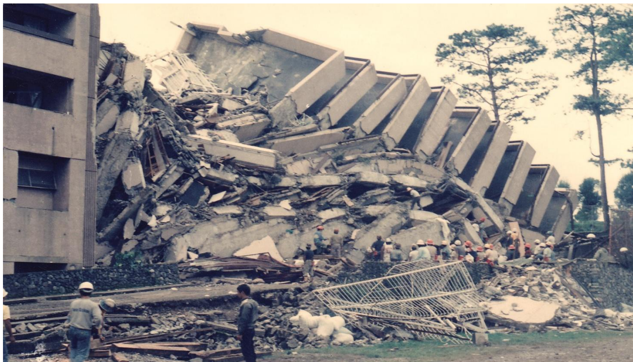
Figura 03: Ruínas do Hotel Hyatt Terraces, em Baguio após o terremoto que atingiu a cidade, Filipinas, em 16 de julho de 1990. Fonte: Gma News Paper, 1990
