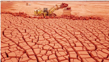
Represa de rejeito da bauxita.
