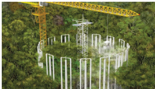
Representação de um dos plots e das torres de injeção de CO 2
