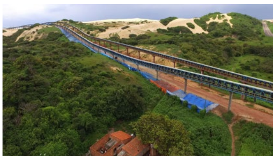
Figura 1 - Esteira Transportadora de Minério
