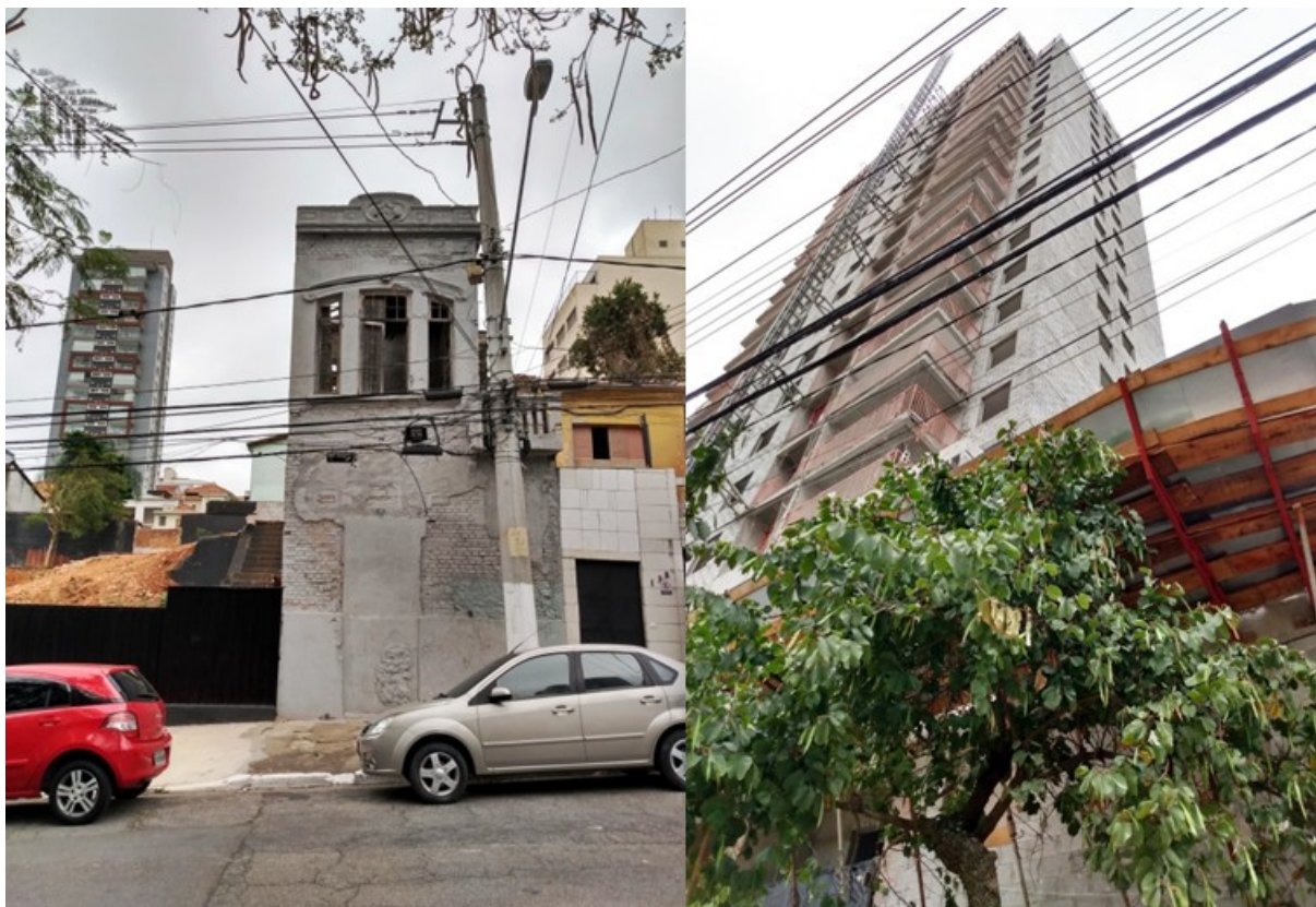
Figura 2 - Imóvel lacrado ao lado de obra em andamento e empreendimento imobiliário em obras – sobre margem de curso d’água oculto.
