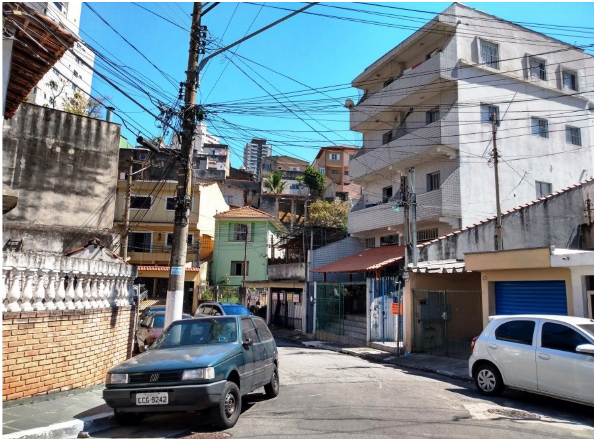
Figura 7 – Trecho da Rua Maranjaí com passagem da água subterrânea. FONTE: GERAR, 2021.
