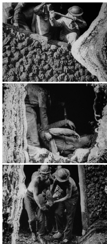
Figura 9, 10 e 11 - trabalhadores resgatados de mina em ruínas
